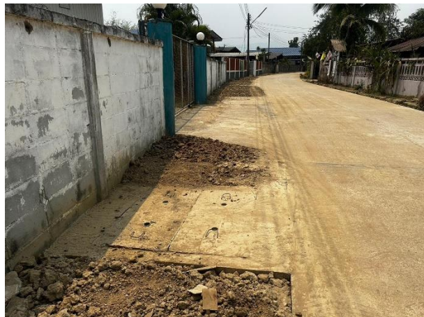
- โครงการวางท่อระบายน้ำ คสล. พร้อมบ่อพัก คสล. หมู่ที่ 8 บ้านท่าทรายมูล งบประมาณ 249,500 บาท
