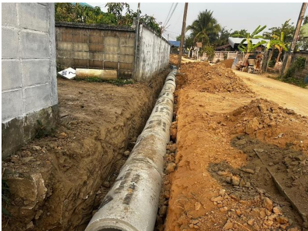
- โครงการวางท่อระบายน้ำ คสล. พร้อมบ่อพัก คสล. หมู่ที่ 8 บ้านท่าทรายมูล งบประมาณ 249,500 บาท
