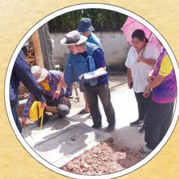
ก่อสร้างรางระบายน้ำพร้อมบ่อพัก
