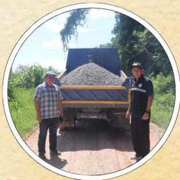
ซ่อมแซมถนนเพื่อการเกษตร
