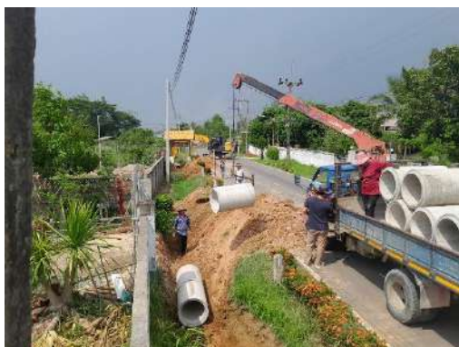
โครงการวางท่อระบายน้ำ คสล. พร้อมบ่อกัก คสล. หมู่ที่ 7 บ้านสันผักอี๊ งบประมาณ 241,500 บาท
